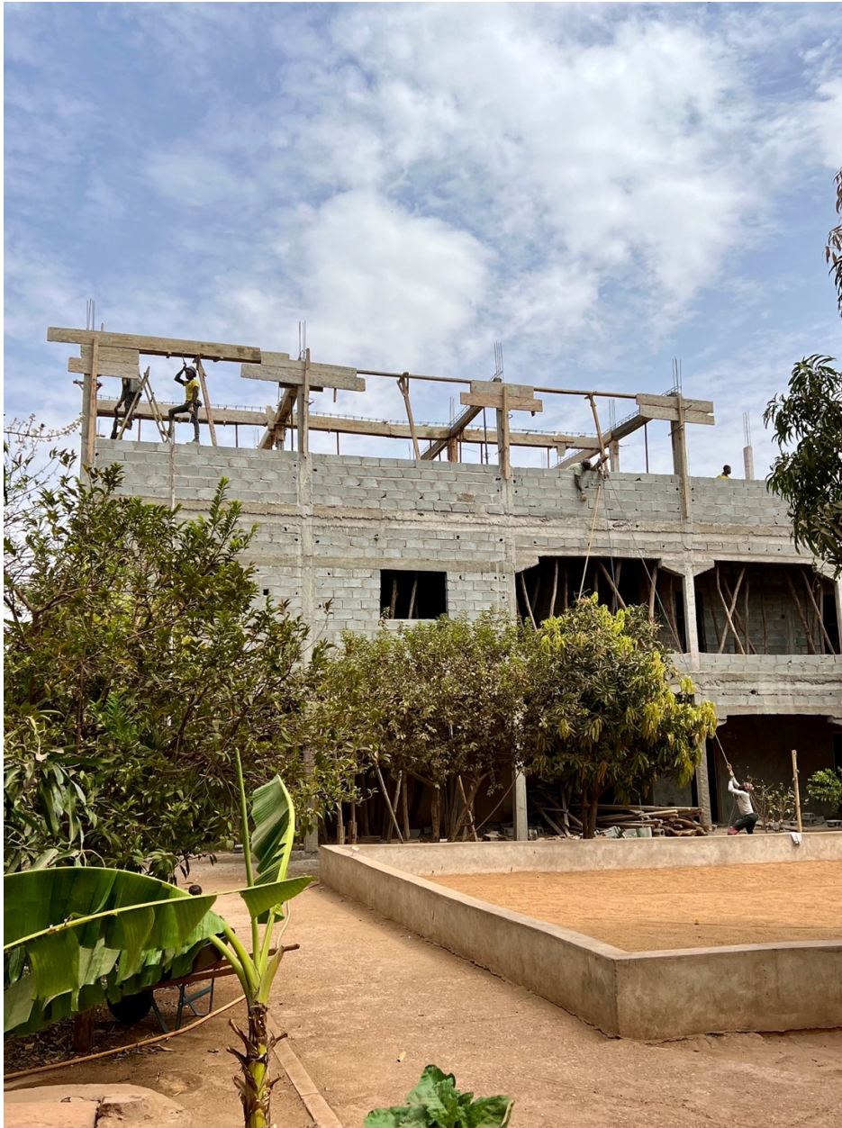
© Gudrun Eisermann: Bauarbeiten Maison 2 Nele Weber
